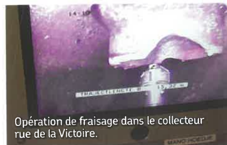
Robot de fraisage que l'on introduit dans le collecteur d'eau usée pour éliminer les raccords pénétrants.
