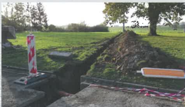
Début des travaux pour réalisation de plusieurs places de parking à la crèche de Momalle
