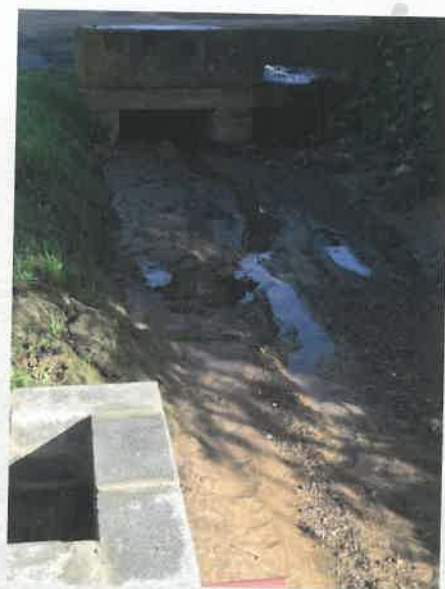
Aménagement des passages sous voirie
