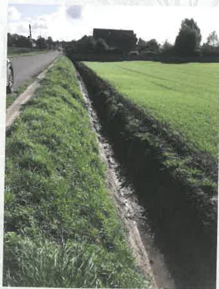
Curage du fossé rue des Héros
